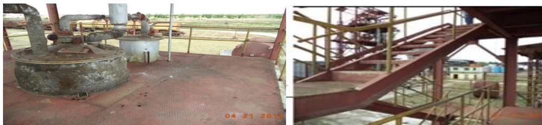
Figura 2. Vistas de la planta de resinas antes de su reubicación e instalación en Cienfuegos
