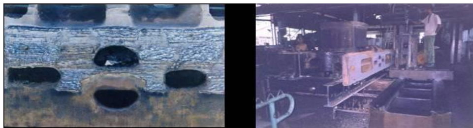
Figura 10. Vistas de la recuperación del bancazo y virgen del tren de molienda con soldaduras metálicas en frío
