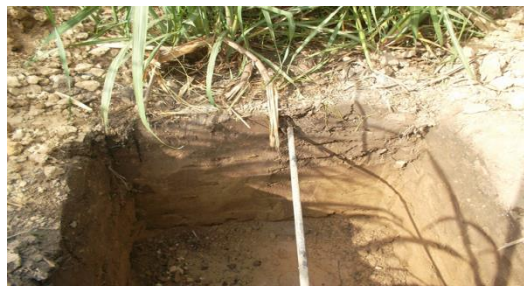
Figura 7.- Manguera de riego por goteo enterrada a 0.16 m
