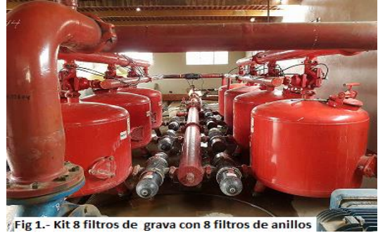
Fig 1.- Kit 8 filtros de grava con 8 filtros de anillos
